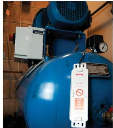
Wenn das Gerät nicht verwendet werden darf oder die Prüfung nicht besteht, wird das Multitag-Einsteckschild aus dem Halter entfernt, der daraufhin sofort wieder das Verbotssymbol mit dem Hinweis „Dieses Gerät nicht verwenden“ anzeigt.
