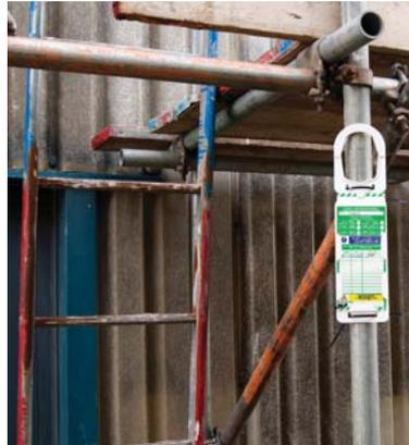
Das Gerüst wird von einer qualifizierten Person geprüft. Die Einzelheiten zum Gerüstaufbau werden auf dem Scafftag-Einsteckschild vermerkt. Wenn das Gerüst sicher verwendet werden kann, wird das Scafftag-Einsteckschild mit Datum und Unterschrift versehen und in den Scafftag-Halter gesteckt.
