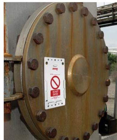
Wenn der Bereich nicht betreten werden darf oder die Prüfung nicht besteht, wird das Entry Tag-Einsteckschild aus dem Halter entfernt, der daraufhin sofort wieder das Verbotssymbol mit dem Hinweis „Nicht betreten“ anzeigt.
