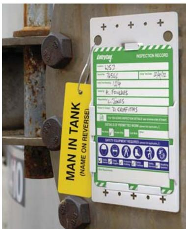
Der Entry Tag-Halter wird mit Kabelbindern, Klebstoff oder Magnetstreifen deutlich sichtbar am Eingang des engen Raums angebracht. Auf dem leeren Entry Tag-Halter wird das Verbotssymbol mit dem Hinweis „Nicht betreten“ deutlich angezeigt.
