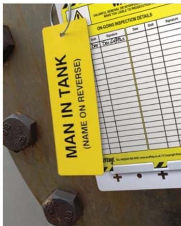
Eine qualifizierte Person führt eine Prüfung durch und vermerkt die Einzelheiten auf dem Entry Tag-Einsteckschild. Wenn der Bereich die Prüfung besteht, wird das Entry Tag-Einsteckschild in den Halter gesteckt.
