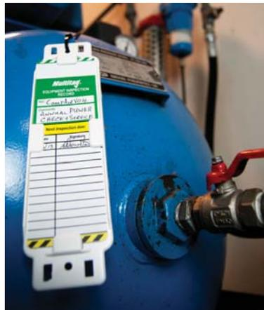
Das Gerät wird von einer qualifizierten Person geprüft. Auf dem Multitag-Einsteckschild werden die Referenznummer des Geräts, zusätzliche Kommentare sowie der nächste fällige Inspektionstermin vermerkt. Wenn das Gerät sicher verwendet werden kann, wird das Multitag-Einsteckschild in den Multitag-Halter gesteckt.
