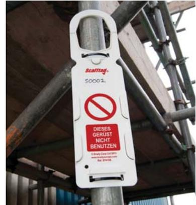
Wenn das Gerüst nicht sicher verwendet werden kann oder die Prüfung nicht besteht, wird das Scafftag-Einsteckschild aus dem Halter entfernt, der daraufhin sofort wieder das Verbotssymbol mit dem Hinweis „Gerüst nicht verwenden“ anzeigt.
