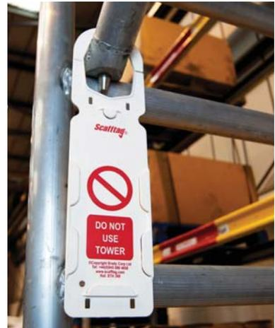
Wenn der Turm oder Mast nicht sicher verwendet werden kann oder die Prüfung nicht besteht, wird das Tower Tag-Einsteckschild aus dem Halter entfernt, der daraufhin sofort wieder das Verbotssymbol mit dem Hinweis „Turm nicht verwenden“ anzeigt.
