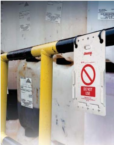
Der Chemtag-Halter wird mit Kabelbindern oder Klebstoff deutlich sichtbar am Aufbewahrungsort oder am Eingang angebracht. Auf dem leeren Chemtag-Halter wird das Verbotssymbol mit dem Hinweis „Nicht verwenden“ deutlich angezeigt.
