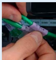
Leitungs- und Kabeletiketten
